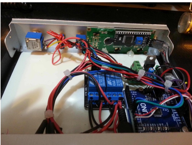
Figura 6: vista d'insieme dell'interno;
